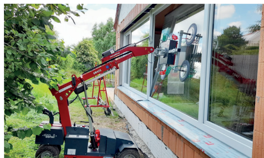
Für den Außeneinsatz geeignet, um Fenster von außen nach innen zu versetzen
