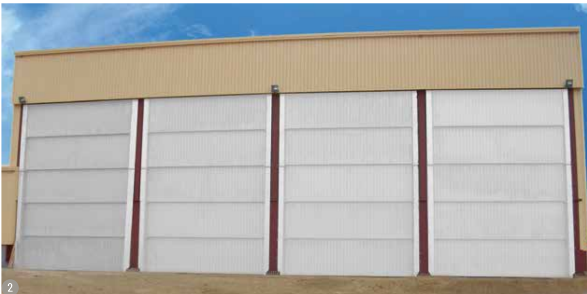
1/ AEROPUERTO DE BEN SLIMANE (MARRUECOS). PUERTA CORREDERA DE 10 HOJAS CON UNA LONGITUD DE 50 METROS Y UNA ALTURA DE 15 METROS. 2/ MINAS DE ORO EN MAURITANIA. CUATRO PUERTAS GUILLOTINA CON UNA LONGITUD DE 9 METROS Y UNA ALTURA DE 12,5 METROS.
