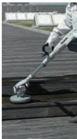
Limpieza de suelos exteriores
