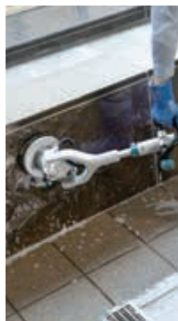
Limpieza en baños
