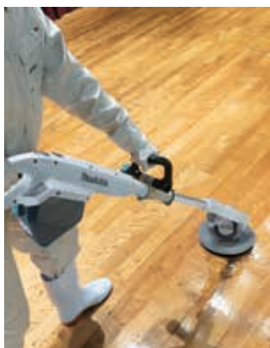
Limpieza y eliminación con cera de resina
