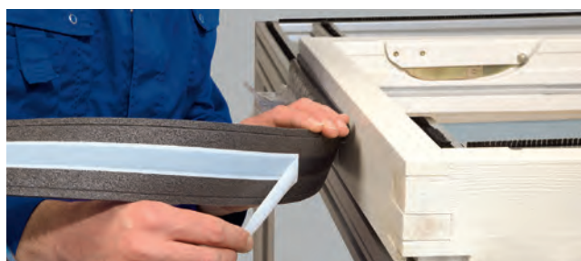
Ejemplo de instalación (1-BT): Instalación en ventana de madera
