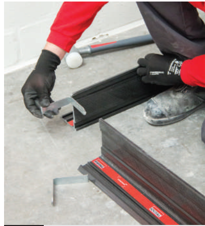
03 Coloque las uniones angulares
